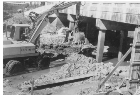
Figura 5. Equipo para el manipuleo de los tubos de alcantarilla
