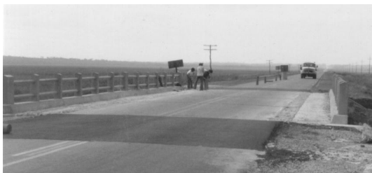
Figura 1. Puente ensanchado tramo San José de los Arroyos-Coronel Oviedo.
