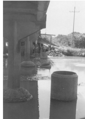
Figura 4. Alineación de tubulones. Puente José P., tramo Luque-Aregua.
