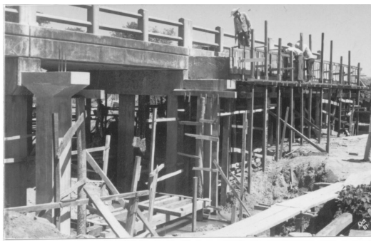
Figura 3. Construcción de pilares
