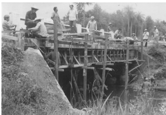
Figura 6. Encofrado sobre reticulado
